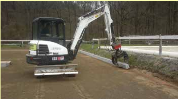
Einbau von RIPROCRETE in einer Reithalle
